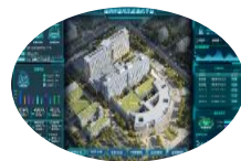
某市医院新院二期工程（智能化）
