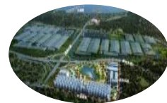
某市粮食储备库电子与智能化工程项目
